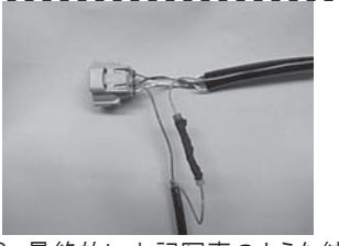
8. 最終的に上記写真のような結線となります。カプラーは、元の圧カススイッチに差し込んで下さい。
